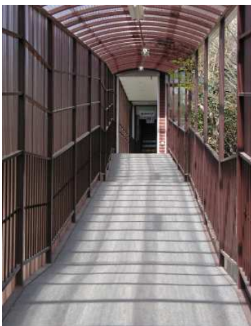
透水性舗道 (嵯峨野観光鉄道(株)トロッコ馬堀駅) 透水性・スリップ事故防止・バリアフリー
